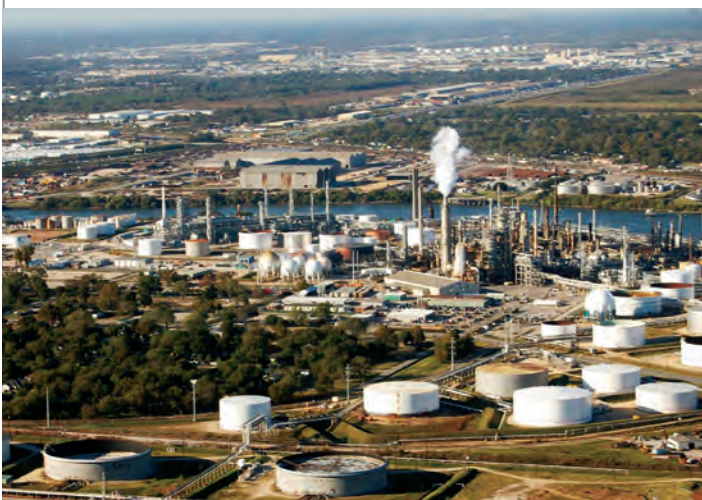
Houston contiene 191 instalaciones químicas de alto riesgo.
